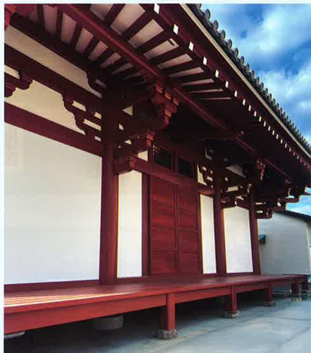
なごみ施工例
